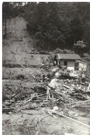
崩落した代田山
